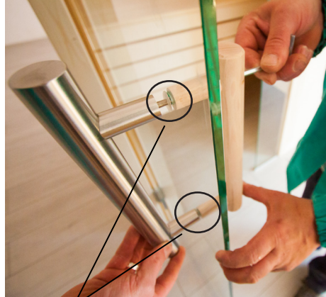
Plastové podložky vložte v prípade nerezovej kľučky
